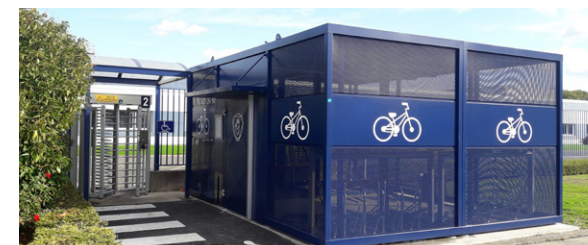
A l'entrée d'un site industriel, ANGERS.
